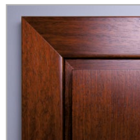
łączenie opasek pod kątem 45°
