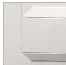
faza na łączeniu ramiaków
