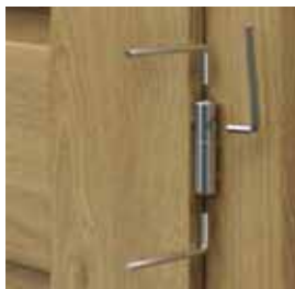
regulacja zawiasów czopowych regulowanych 3D
